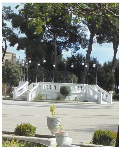
Fig. 7 – Struttura fissa in muratura progettata nel 1922 come palco stabile per ospitare i concerti bandistici. È comunemente chiamata “L’Orchestra”. Villa comunale di San Severo. (foto degli anni ‘90).
