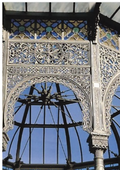
Fig. 2 – Particolare del merlettato in ferro battuto e dei vetri colorati montati a piombo della stessa Cassa armonica, recentemente restaurata (foto del maggio 2023). Fu realizzata nel 1900 su un progetto dell'ingegner Eugenio Cosenza; tutte le parti in ferro furono realizzate dalla fonderia Minieri di Napoli.
