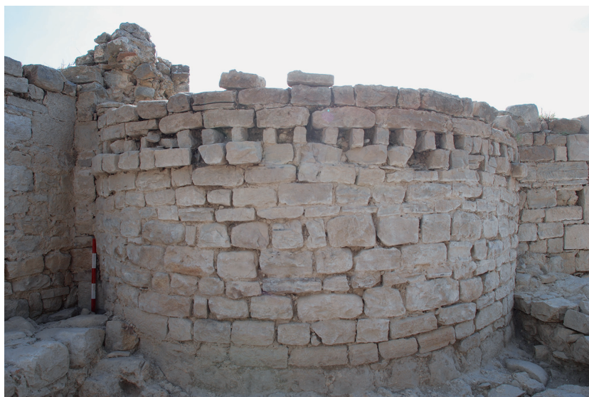
Fig. 9 – L'abside laterale della cattedrale di Montecorvino con la cornice a dentelli.
