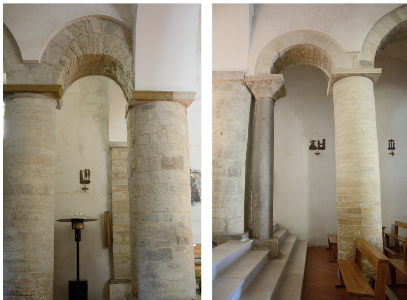
Fig. 8 – Cattedrale di Volturara. Particolari dell'innesto della navata centrale al presbiterio: si notano le ridotte dimensioni delle due arcate terminali e l'utilizzo di elementi di reimpiego come la colonna in granito.
