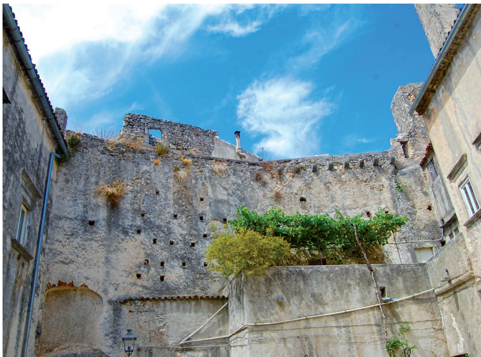
Figura 2 – Prospetto W interno del castello.
