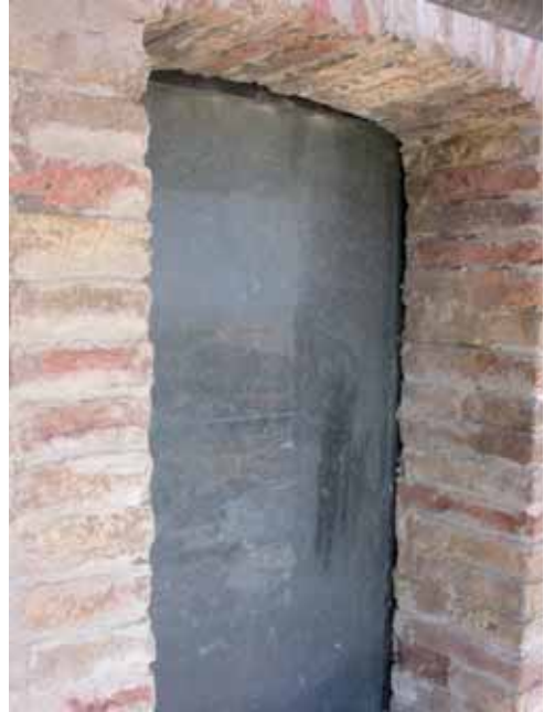
Fig. 10. Apertura di tipo 5: finestra ad arco ribassato in laterizi.
