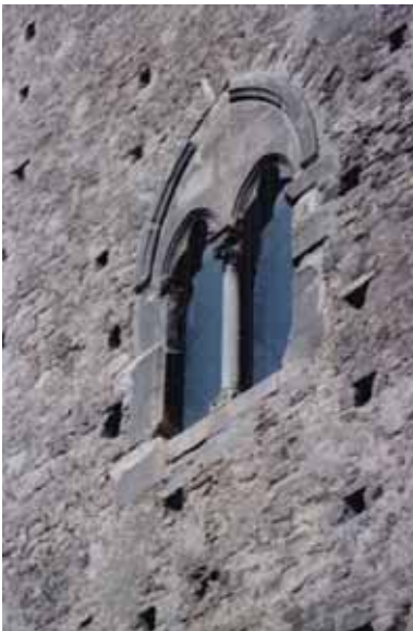
Fig. 6. Apertura di tipo 1: bifora posta sulla parete meridionale della torre.
