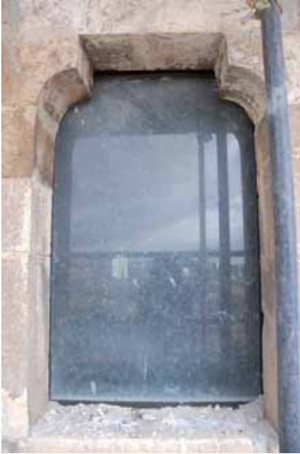
Fig. 9. Apertura di tipo 4: finestra sormontata da arco "a spalla".
