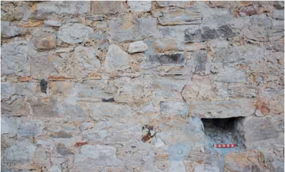
Fig. 11. Particolare della tessitura muraria.
