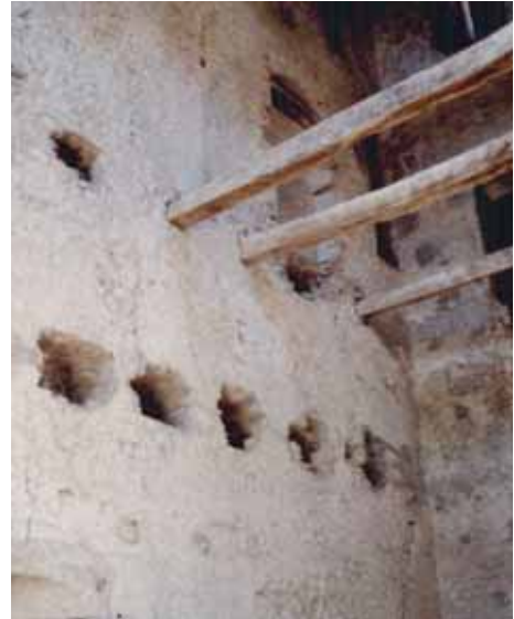
Fig. 3. Interno della torre con particolare delle travi lignee di sostegno dei solai e delle nicchie ricavate nelle murature.
