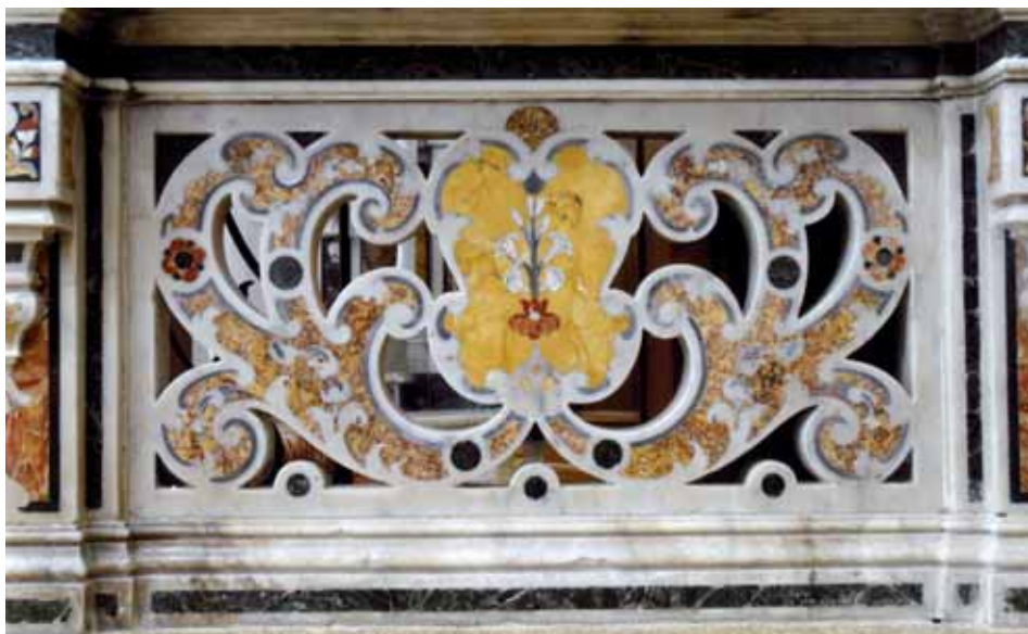
Fig. 6 – Monte Sant'Angelo, chiesa di San Nicola, particolare della balaustra settecentesca.
