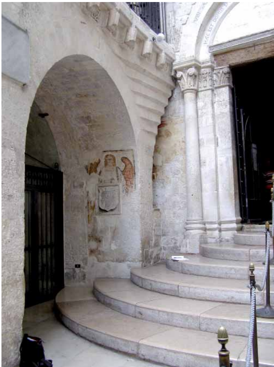
Fig. 15 – Monte Sant’Angelo, Basilica di S. Michele, atrio inferiore, arcata a sinistra dell’ingresso alla grotta.
