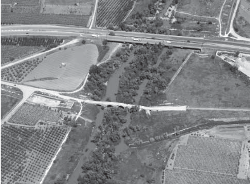
Fig. 9 – Veduta aerea prospettica del ponte sul fiume Ofanto (Archivio LabTAF).
