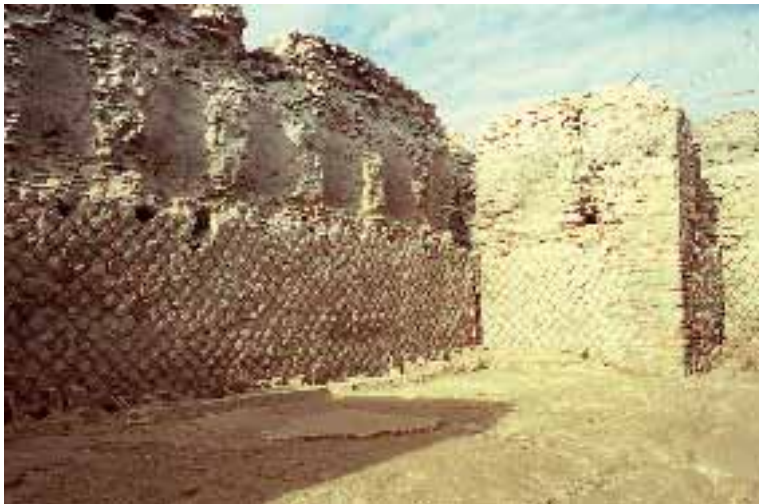
Fig. 8 - Dettaglio della sequenza di piccole nicchie lungo le pareti del caldarium.
