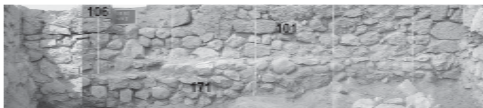
Fig. 4 – Ambiente II-IV: prospetto interno del perimetrale Sud Ovest, zona Nord.
