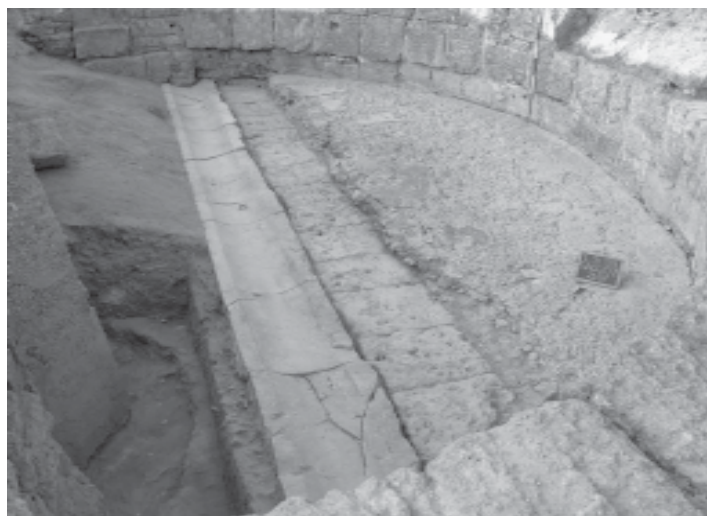
Figura 3 - Canosa - loc. San Leucio, Saggio I: canaletta, struttura di fondazione in blocchi e successiva pavimentazione in cocciopesto (all'interno dell'abside occidentale esterna della basilica).
