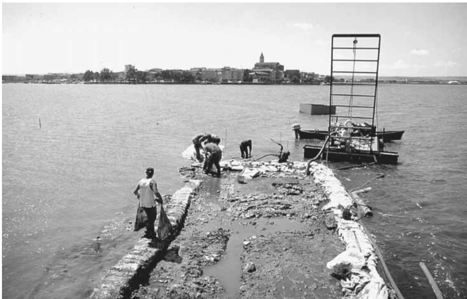
Fig. 2 - Sezione di scavo, in particolare arginatura con sacchetti in tessuto non tessuto e sorbona.
