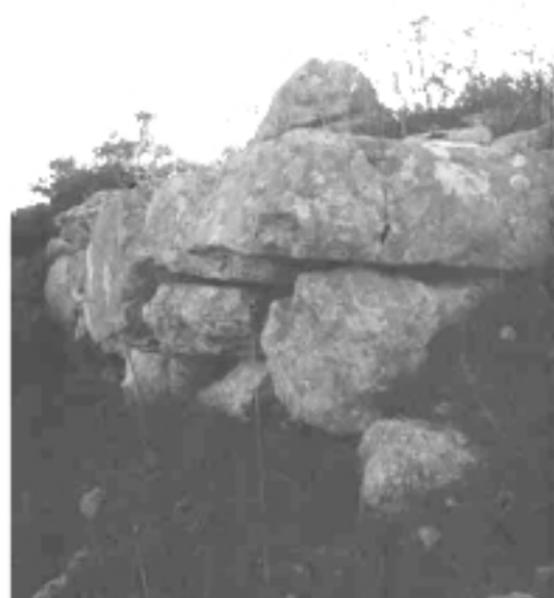
*Fig. 31 - Crocicchia (San Giovanni Rotondo): struttura di contenimento di uno dei terrazzamenti.*
