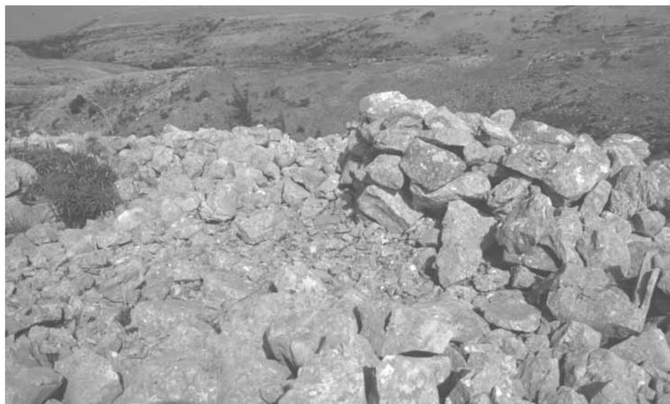
*Fig. 27 - Crocicchia (San Giovanni Rotondo): materiale di crollo della “torre” con il pietrame piccolo che riempie l’intercapedine fra le pareti esterna e interna del muro.*
