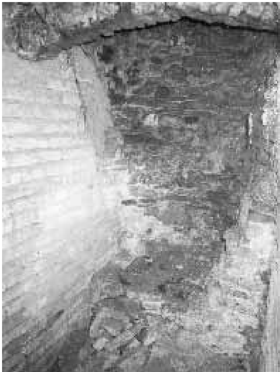
Fig. 22 - Esterno del camino nella zona delle cucine - vano 5
