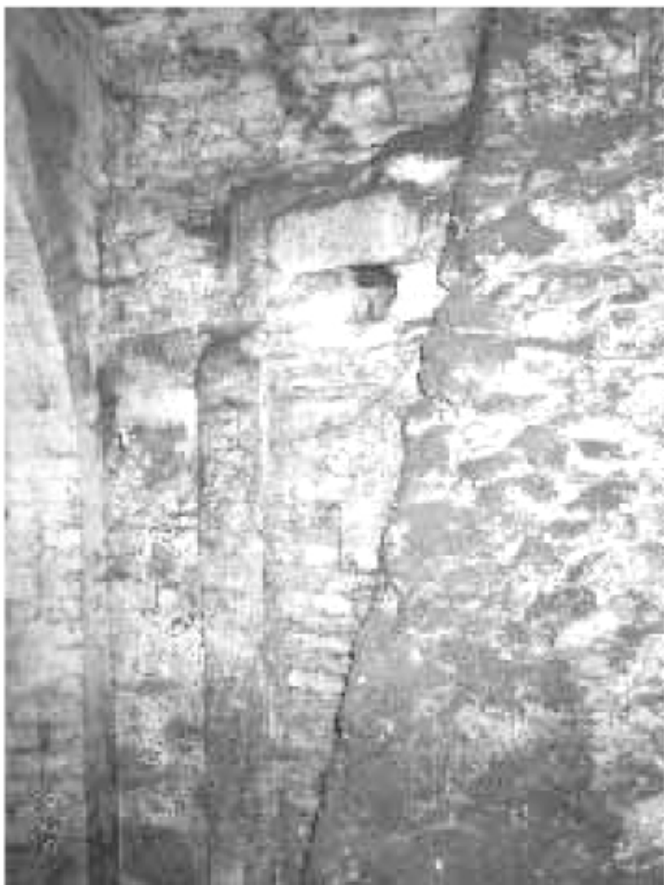
Fig.12 - tratto esterno della torre della Regina, è visibile sia il muro a scarpa che la mezza colonna sulla superficie della torre - vano 3
