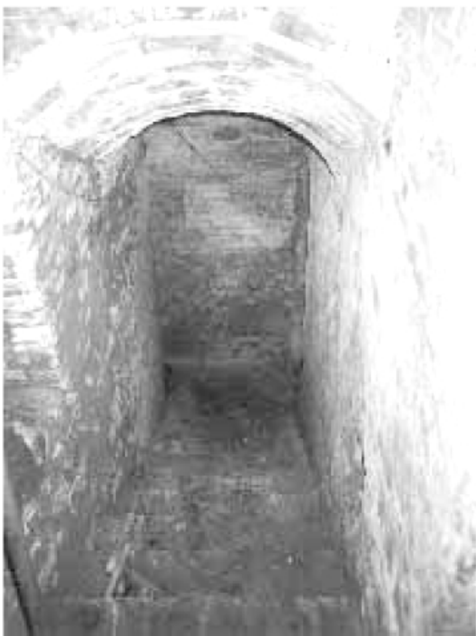
Fig. 10 - Scaletta ottocentesca che dal locale a pianoterra conduce all'ambiente con il forno - vano 6
