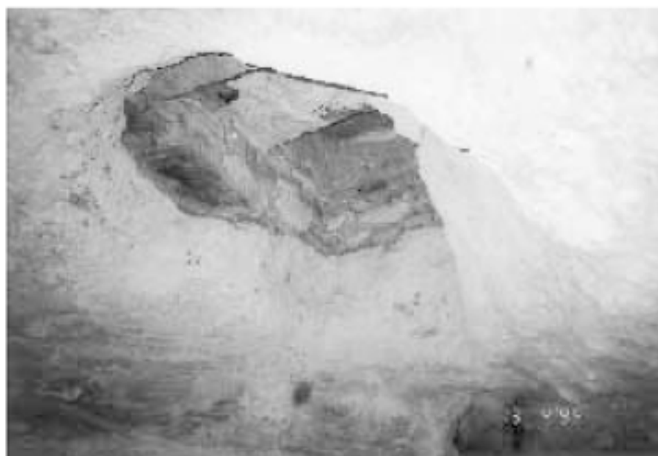
Fig. 7 - Bocca della cisterna sotto il vicololetto senza uscita - vano I
