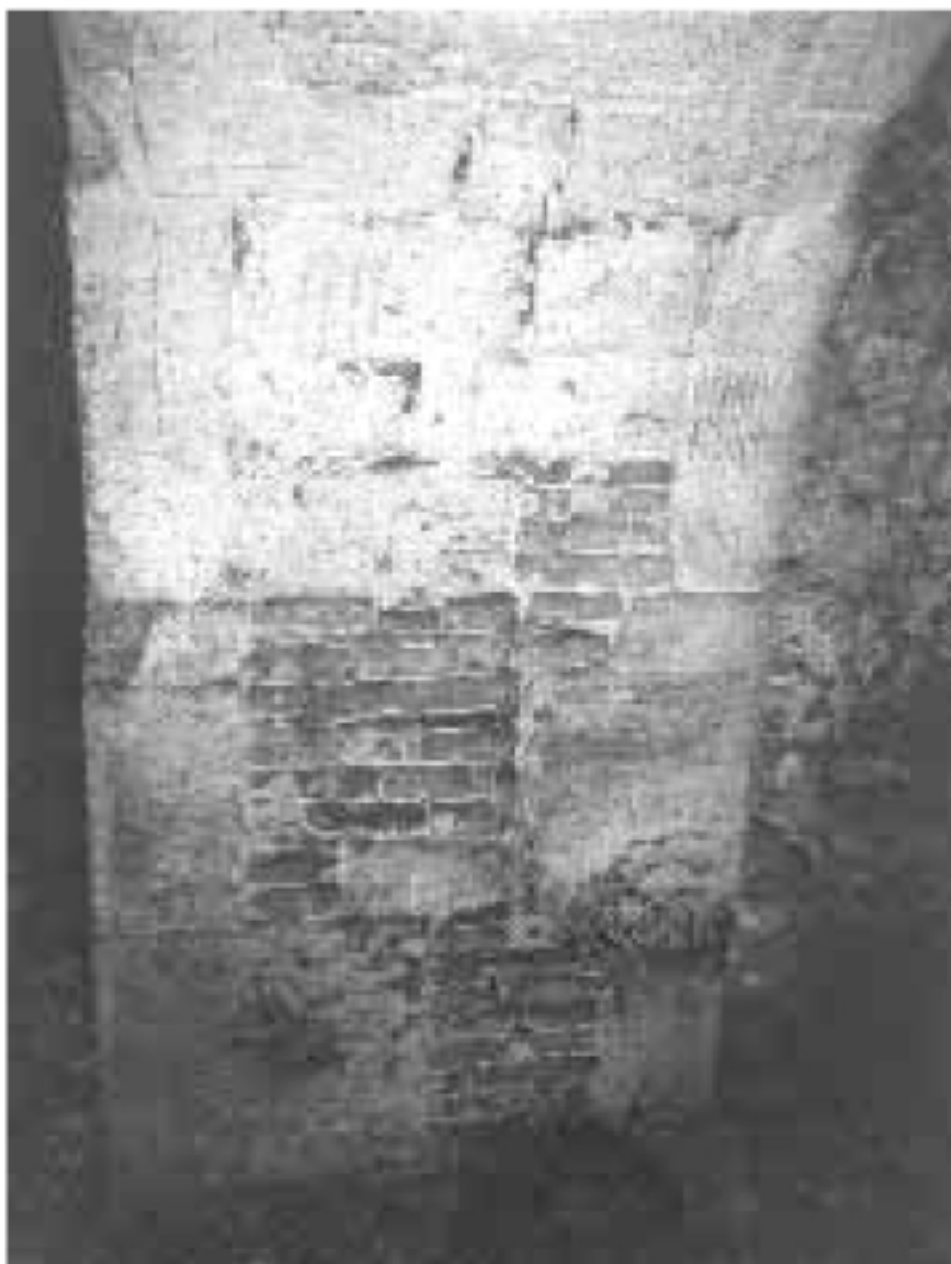
Fig. 11 - Lato interno dell' "arco morto", caratterizzato da striature orizzontali - vano 1
