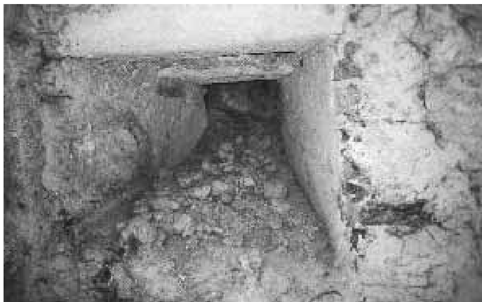
Fig. 18 - Finestrino strombato per illuminare una piccola cella - vano 2
