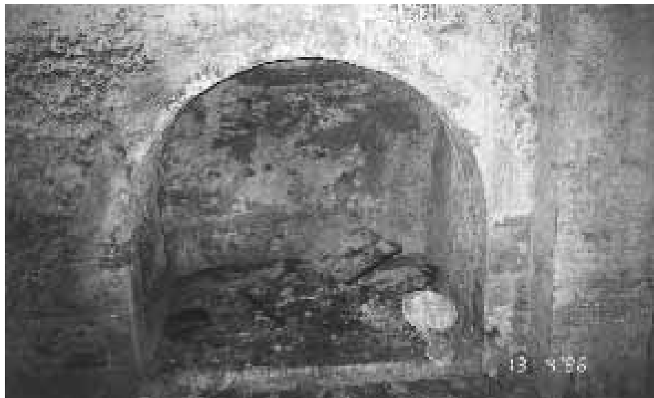
Fig. 17 - Esterno dell'«arco morto», un tempo passante - vano 1
