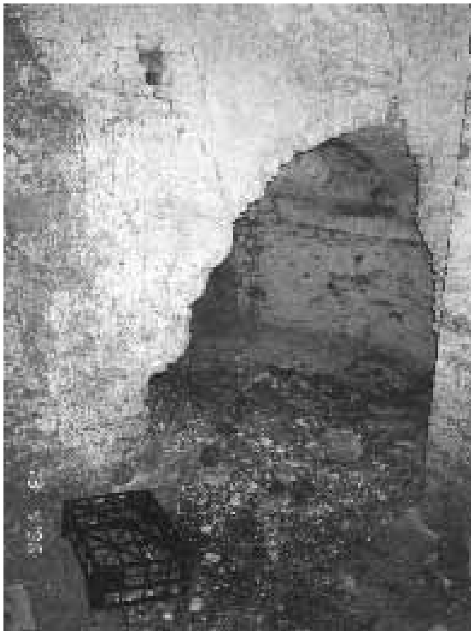
Fig. 15 - Apertura sbrecciata nella torre ad est - vano 1
