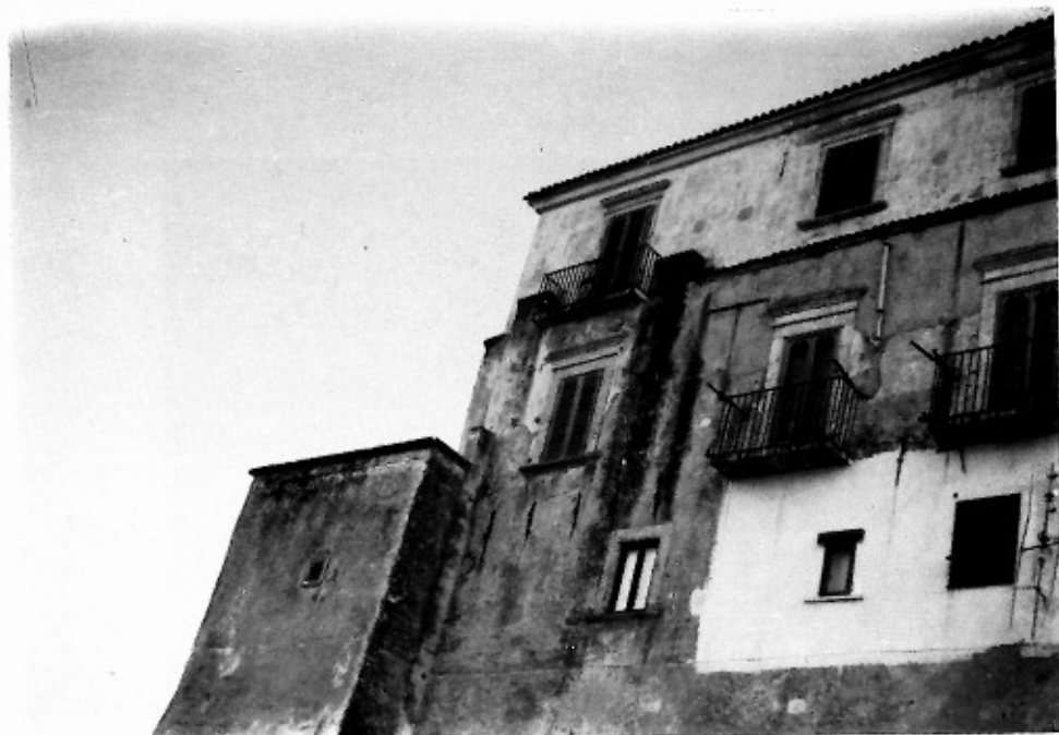
Fig. 7 - Rodi Garganico, Torre e cortina muraria
