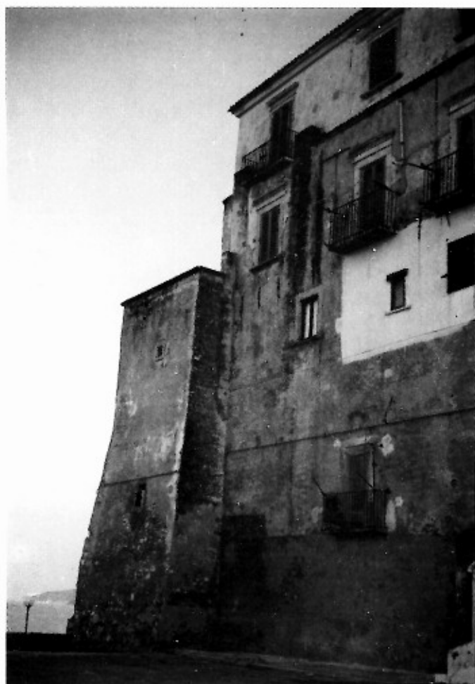
Fig: 6 - Rodi Garganico, Torre e cortina muraria
