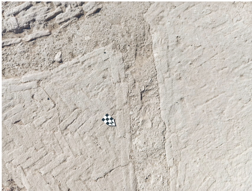
Fig. 5 – Dettaglio del pavimento e della canalina.
