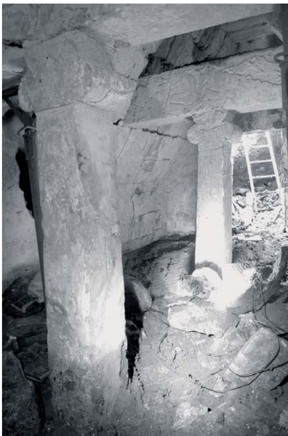
Foto 2 – Interno Tomba in evidenza le colonne in stile ionico-tuscanico.
