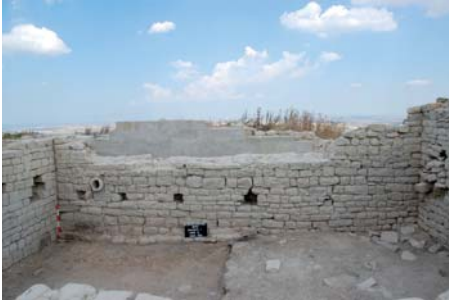
Fig. 16 – Dettaglio della parete orientale dell'ambiente 5 con il tubulo incassato nella cortina (sulla sinistra) e gli incavi deputati all'alloggiamento di travi di sostegno. Vista da Ovest.
