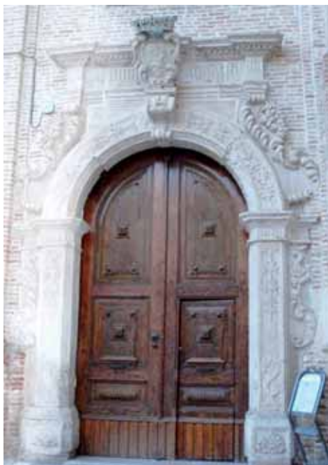
Fig. 2 – San Severo, ex Convento di San Francesco. Prospetto principale, portale.
