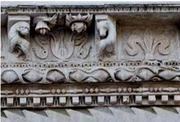
Fig. 22 – Foggia, cattedrale, facciata, cornice marcapiano, particolare.
