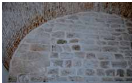
Fig. 1 – Convento di San Matteo, attuale sacrestia, lacerto del muro perimetrale nord della chiesa medievale.
