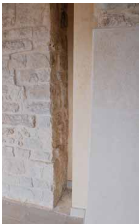
Fig. 3 – Portico del piano superiore, cantonale sud-est della chiesa medievale.
