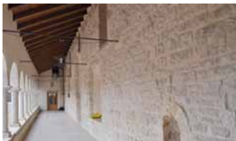
Fig. 2 – Portico del piano superiore, muro perimetrale sud della chiesa medievale.
