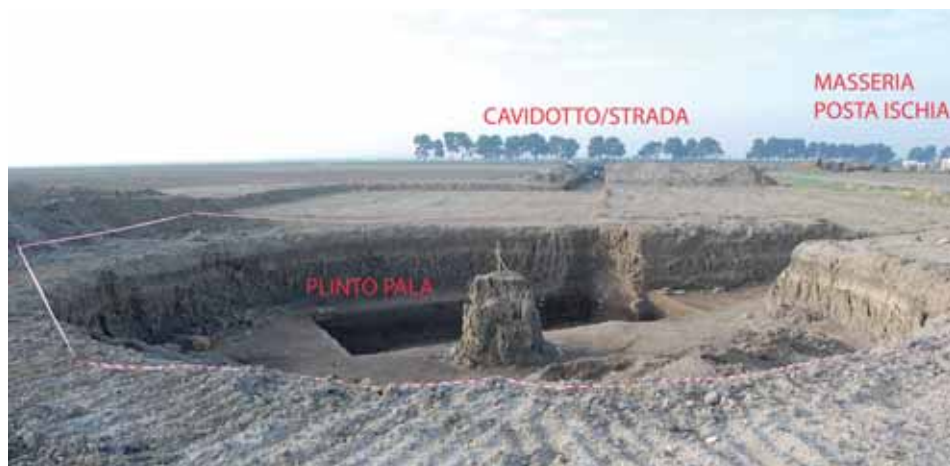
Figura 3. Panoramica generale dell'area di scavo da Nord: in primo piano il plinto dell'aerogeneratore (saggio I); in lontananza, la trincea del cavidotto/strada (saggi III-IV e V); sulla destra si scorge la Masseria Posta Ischia.
