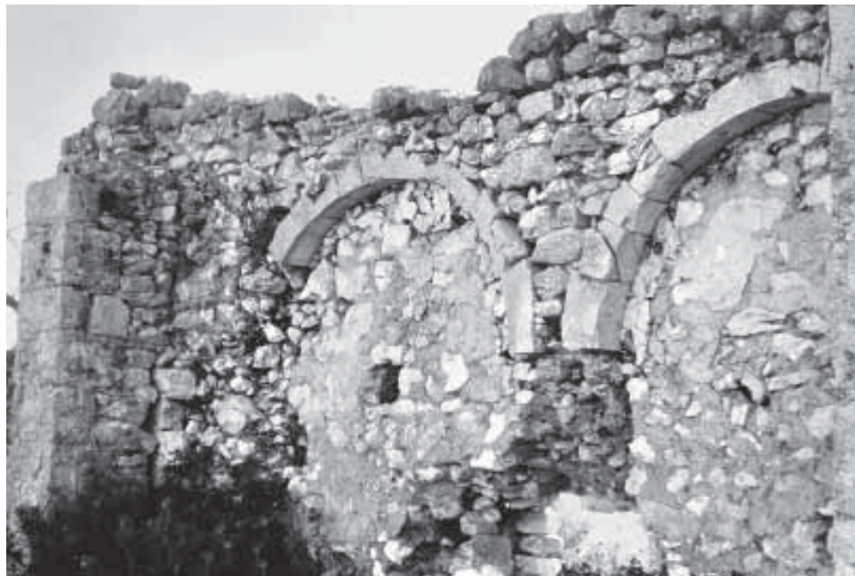
Fig. 16 - Veduta dell'interno, arcate cieche longitudinali.
