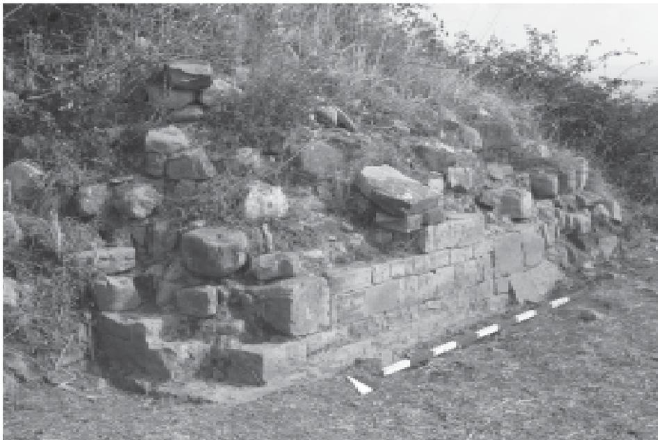
*Fig. 11 - Particolare della robusta struttura con profilo a scarpa, ubicata in corrispondenza della facciata della chiesa.*
