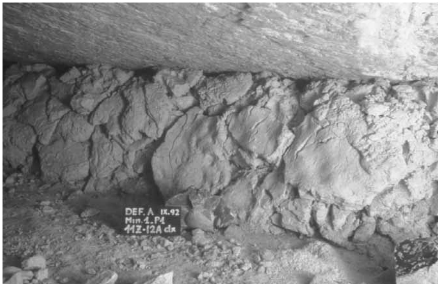
Fig. 6: (a) un esempio di muretto a secco con disposizione non strutturata associata all'utilizzo di blocchi poliedrici; (b) una porzione del muretto a secco intonacato con placche di un fango calcareo nel corridoio N (fot. A. Galiberti)
